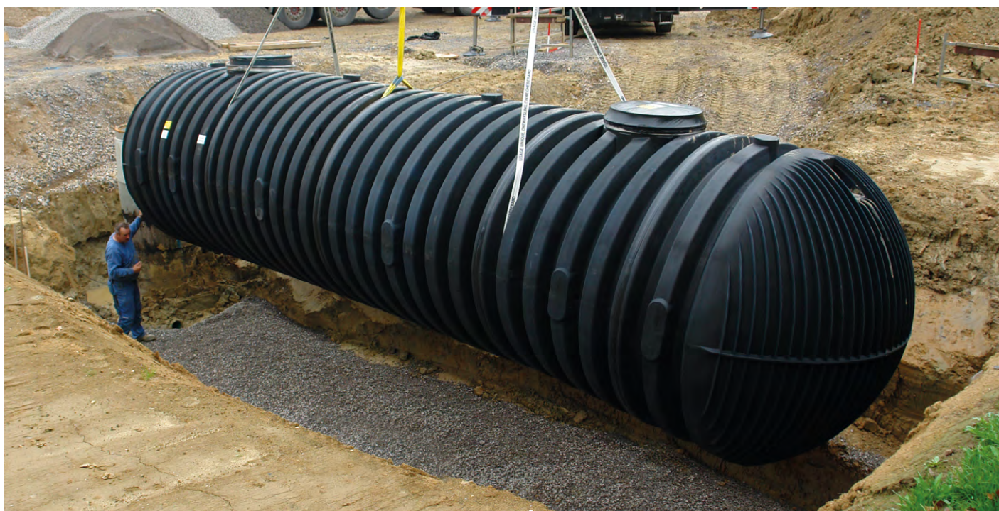
Montáž podzemní nádrže CARAT
